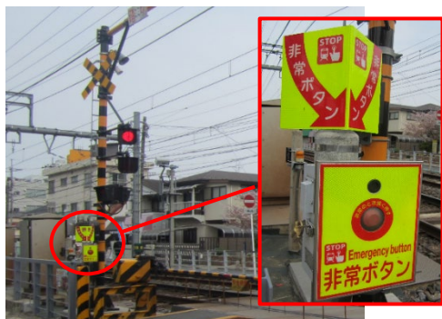
踏切支障報知装置（非常ボタン）
