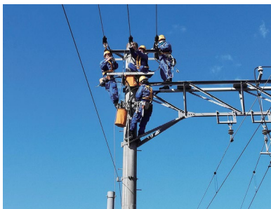
ケーブルヘッド交換の様子
