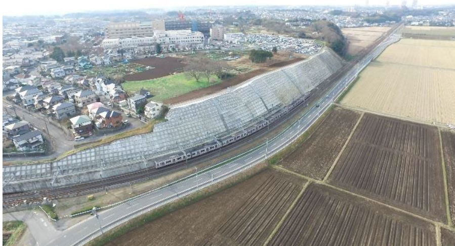
京成臼井～京成佐倉間の法面補強
